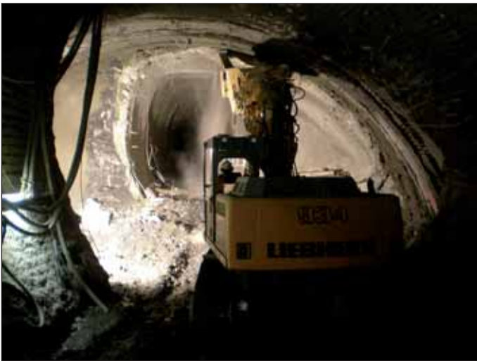
Obr. 6 Ražba tunelu z výhybny průzkumné štoly Fig. 6 Tunnel excavation from the passing bay in the exploration gallery
