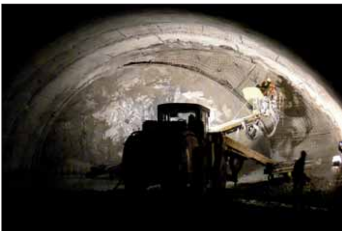
Obr. 1 Poslední záběr v odstavném zálivu dvupruhového tunelu při ražbě od Cholupic
