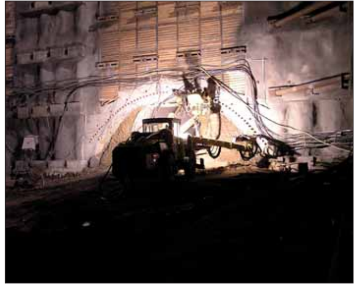
Obr. 9 Vrtání a osazování mikropilotového deštníku na komořanském portálu třípruhového tunelu
