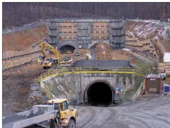
Obr. 7 Odhalená přístupová štola v ose třípruhového tunelu
