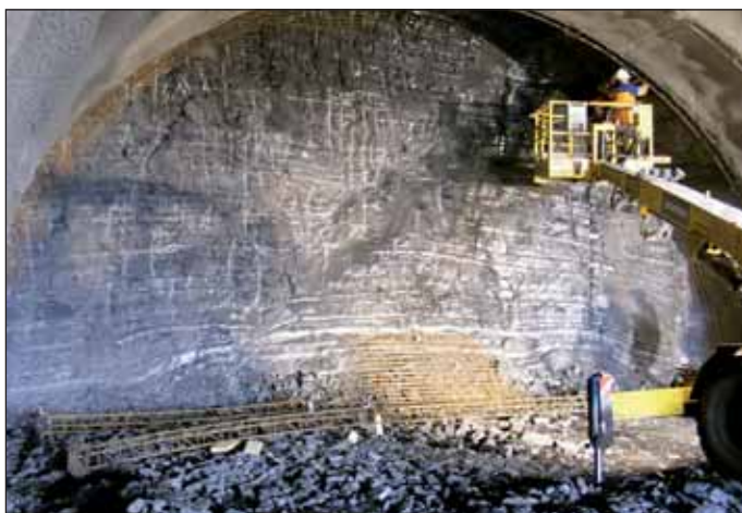
Obr. 2 Typická čelba v příportálové oblasti dvoupruhového tunelu u Komořanského portálu
