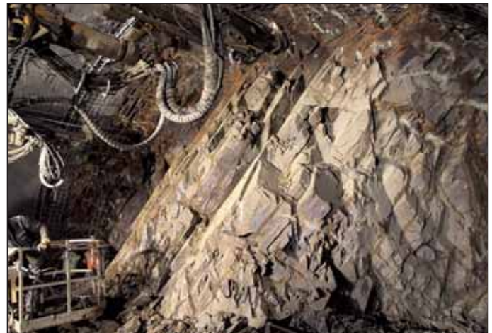
Obr. 3 Typická čelba v příportálové oblasti dvoupruhového tunelu u Cholupického portálu
