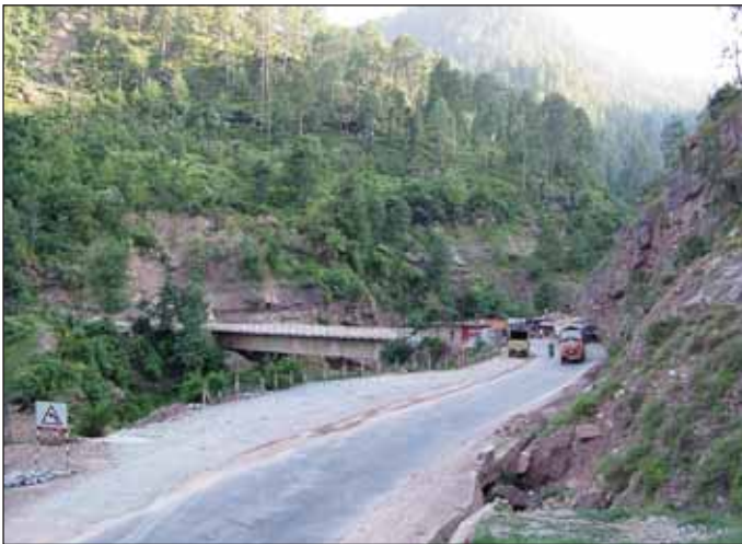
Obr. 2 Severní portál tunelu Fig. 2 Northern tunnel portal
