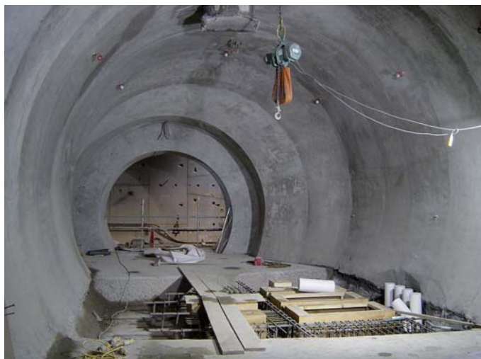
Obr. 26 SB III využitý pro trvalé jednoplášťové ostění
