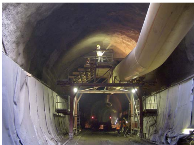
Obr. 24 Nástřik betonu SB I pro vyrovnání povrchu pod izolací
