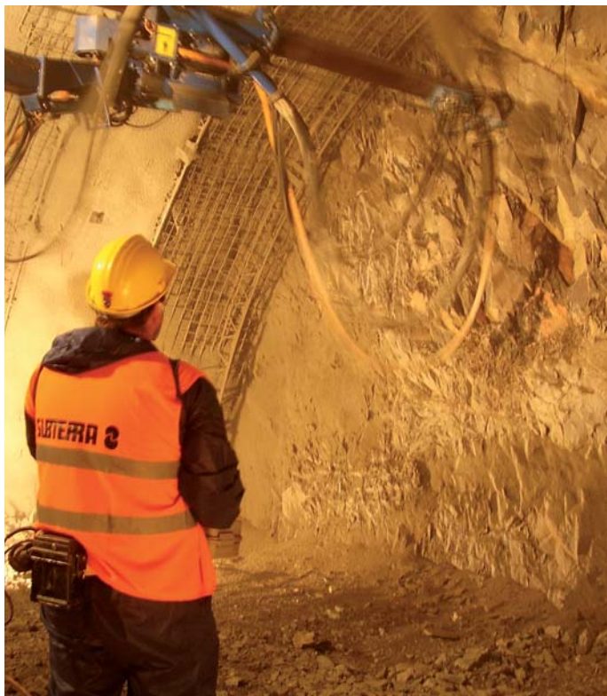
Obr. 22 Vyplňování nadvýlomů stříkaným betonem
