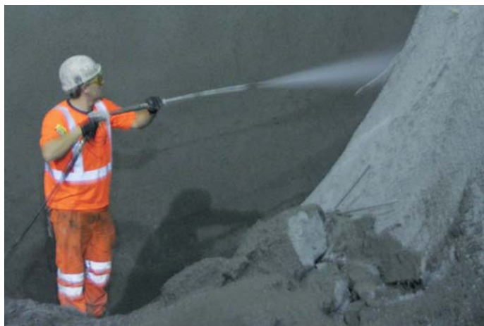
Obr. 16 Začišťování podkladu proudem tlakové vody
