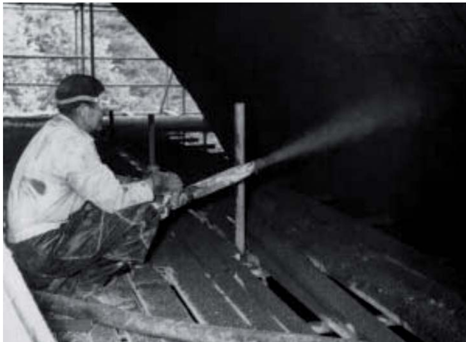
Obr. 3 Sanace Sychrovského tunelu
