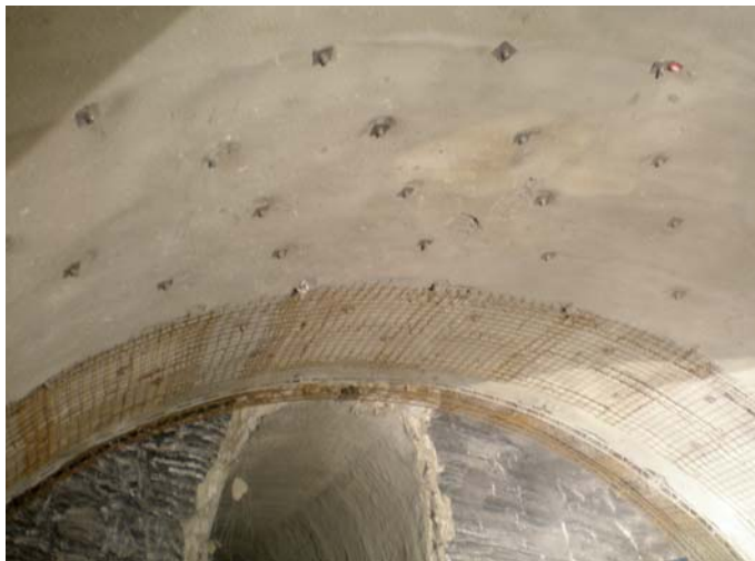
Obr. 25 SB II využitý pro primární ostění
