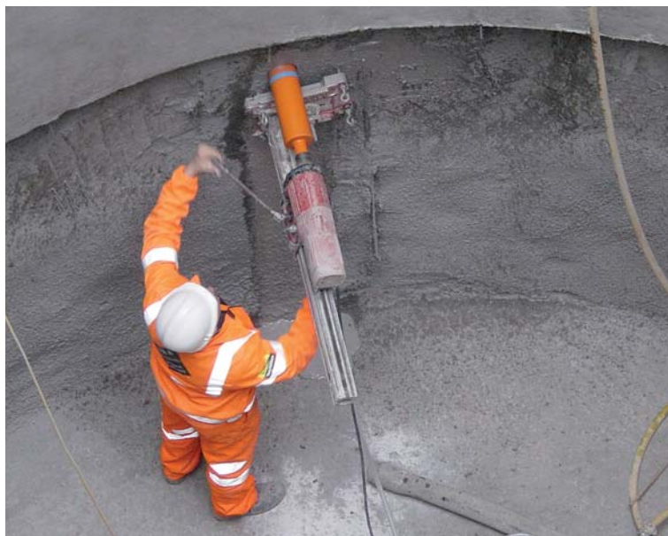
Obr. 33 Odebírání jádrového vývrtu z ostění
