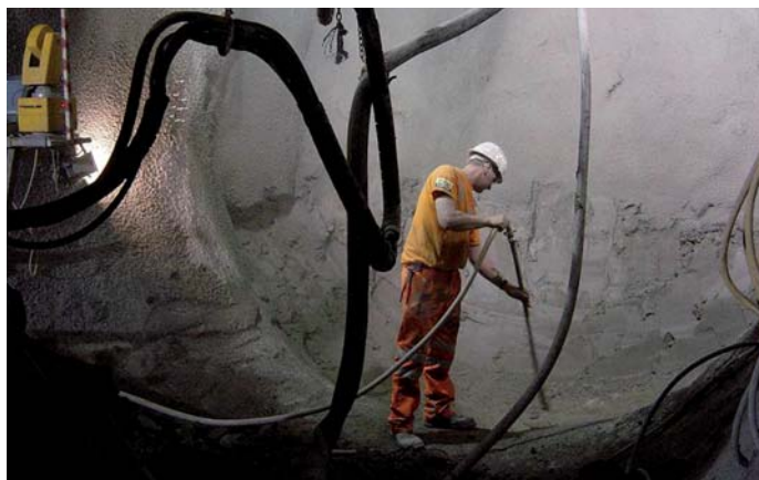
Obr. 15 Začišťování odtěženého dna tlakem vzduchu
