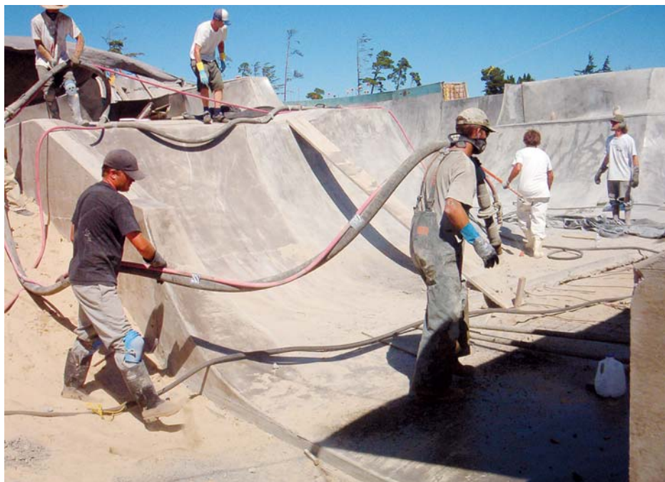
Obr. 41 Výstavba skateboardového parku s využitím stříkaného betonu
