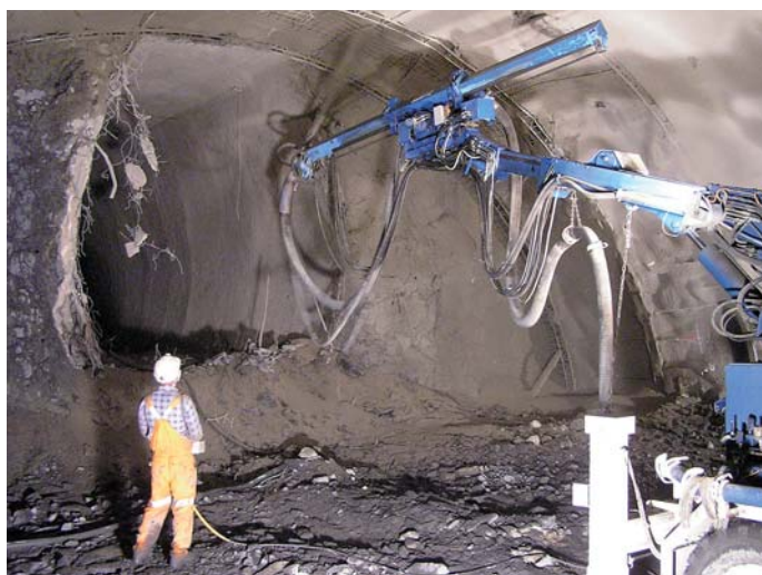
Obr. 20 Pozice operátora trysky při využití manipulátoru
