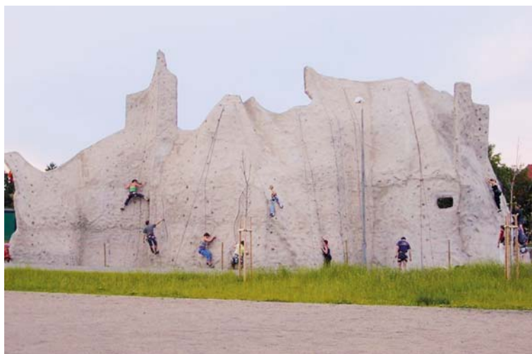
Obr. 40 Lezecká stěna vytvořená ze stříkaného betonu
