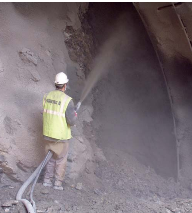
Obr. 1 Ruční způsob nástřiku
