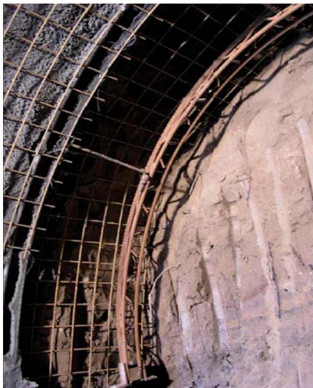
Obr. 19 Ocelové sítě před provedením nástřiku
