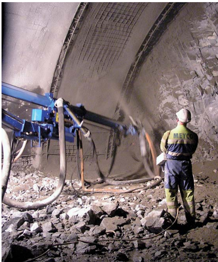
Obr. 2 Nástřik pomocí manipulátoru
