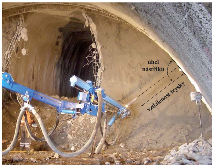
Obr. 17 Směr nástřiku a vzdálenost trysky
